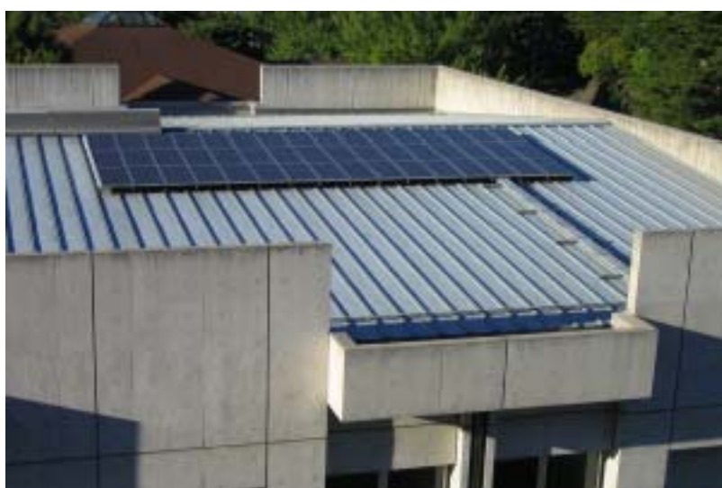
太陽光発電設備（TAUホール屋上）
