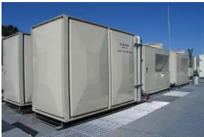
氷蓄熱槽（本部棟屋上）
