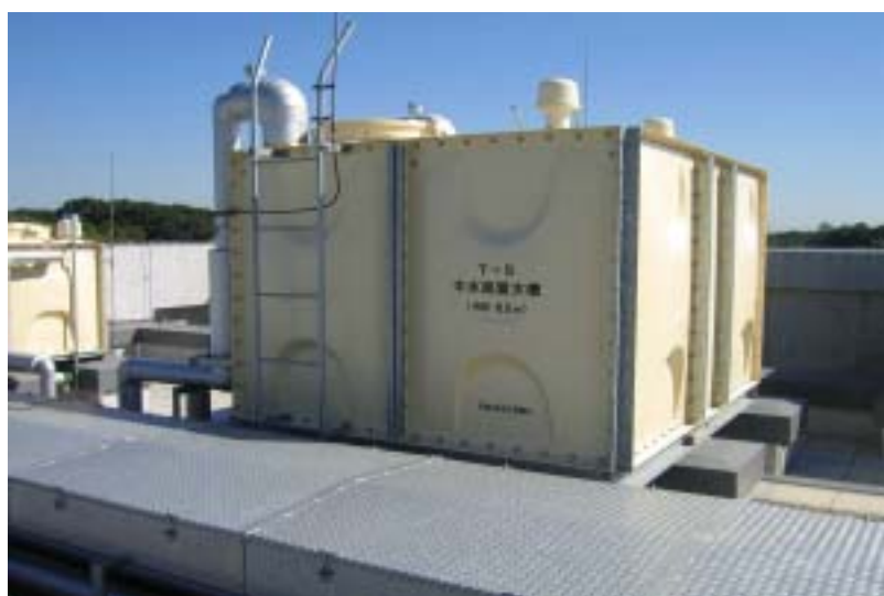
中水高架水槽（本部棟屋上）
