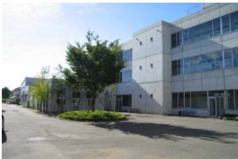
コンクリート打ち放しの校舎（彫刻棟）
