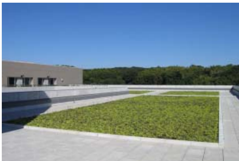
屋上緑化（本部棟屋上）
